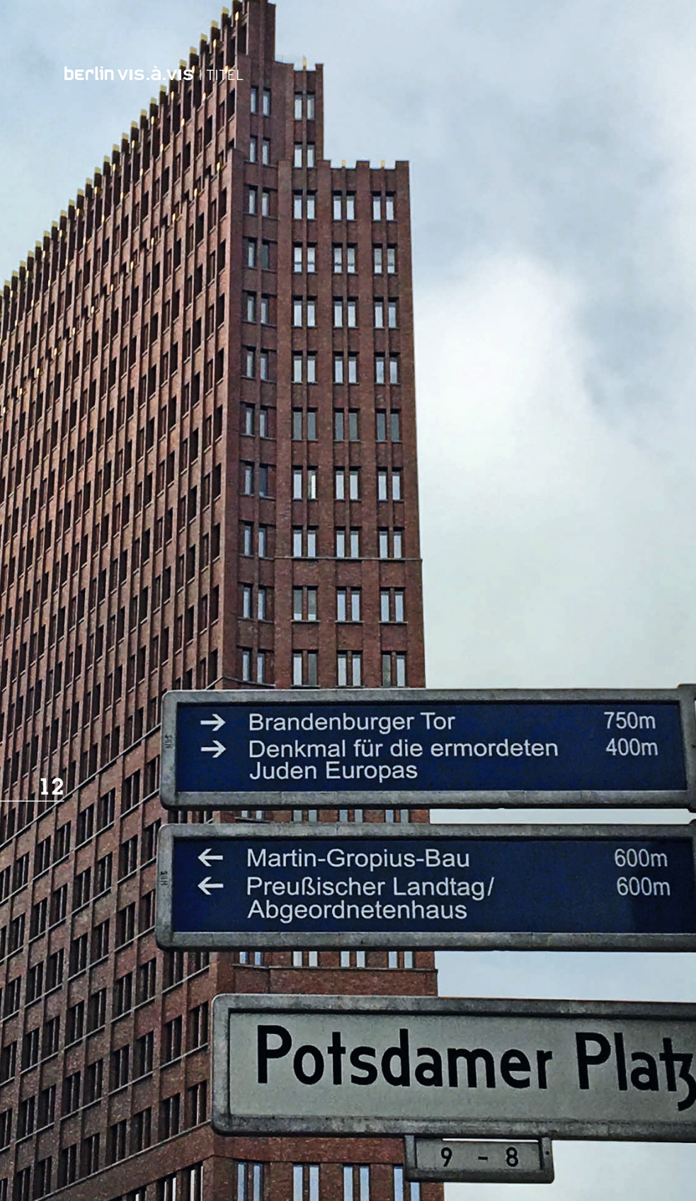
Kollhoff-Tower am Potsdamer Platz
